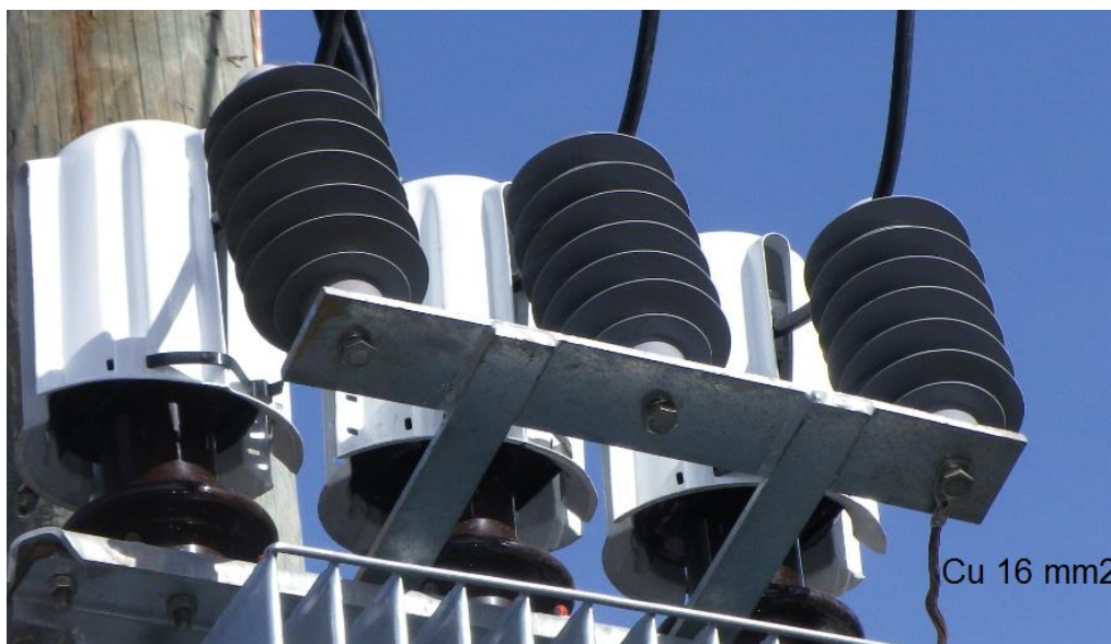
Joonis 4. Piirikute ühendamine mastalajaamas terasest kandetarindi olemasolul, S \geq 50 \text{ mm}^2 .
